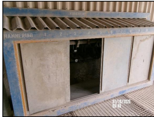
ภาพที่ 3.53 Casing หุ้มชุด Hammering Equipment ในหม้อไอน้ำ
